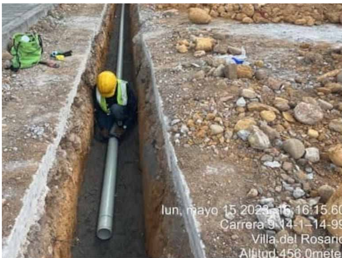
Trabajos de acueducto en Villa del Rosario - Foto: Referencia
