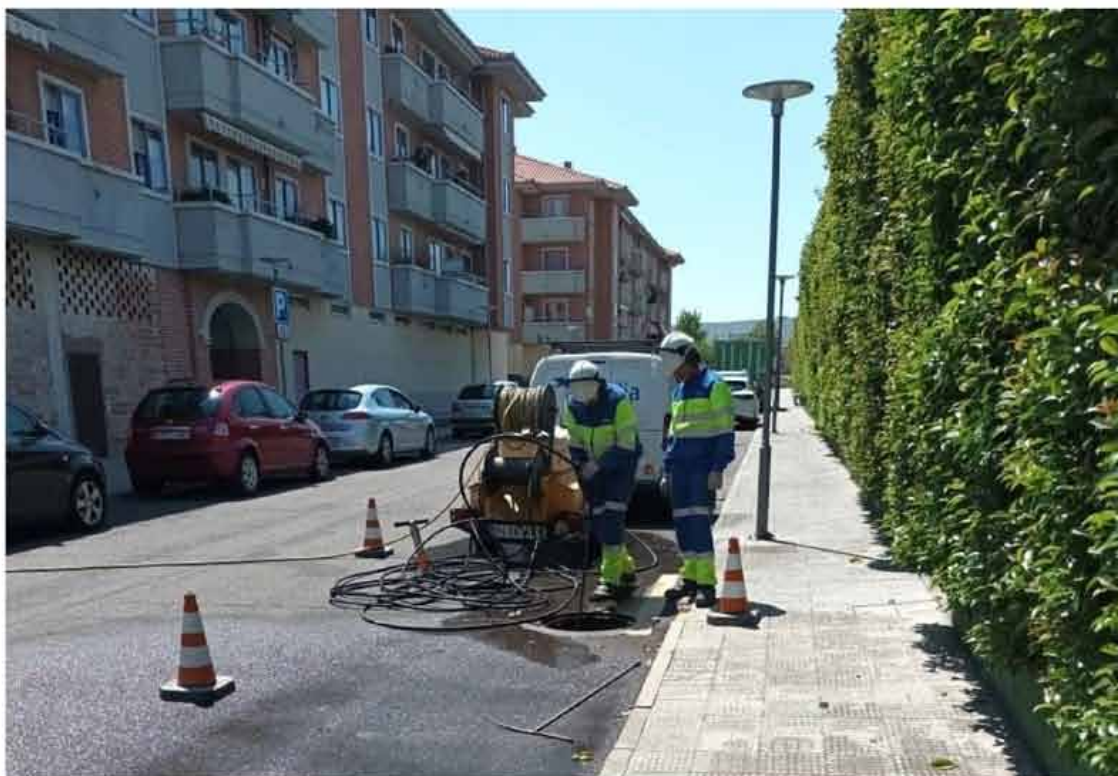
Dos operarios durante los trabajos de limpieza de las alcantarillas en Santa Marta
