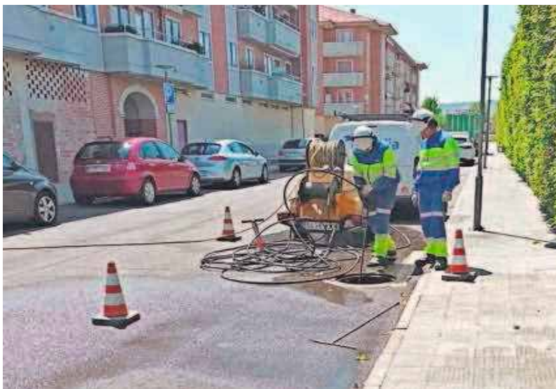
La limpieza del sistema de alcantarillado en Santa Marta de Tormes. FOTOS: EÑE
